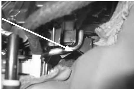
Kuva 5-19: Vaimennusmatto irrotettu keskitunnelista
