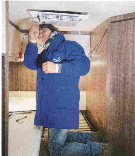
Montage und Einstellung des Innenluftverteilers waren ebenfalls Aufgabe der Techniker.
